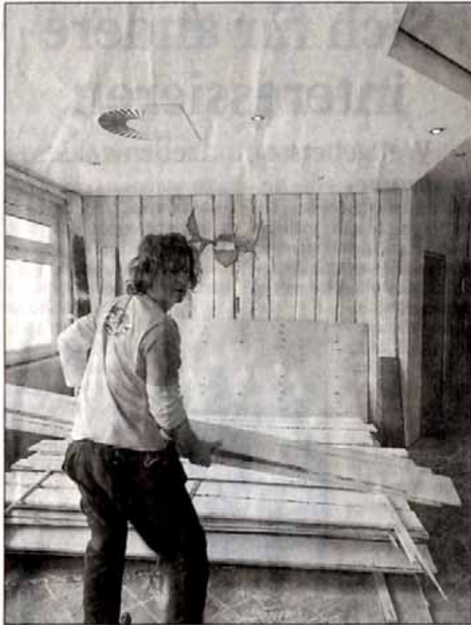
Zimmerer Marcus Butzek schneidet die Fichtenbretter zu, mit denen die Wände des Restaurants verkleidet werden.
