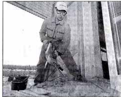
Auf der Terrasse verschwinden die Fliesen. Stattdessen werden Holzdielen verlegt.
